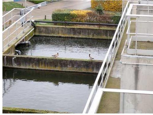
Bassin de traitement biologique avec injection d'air      bassin de traitement biologique sans injection d'air
