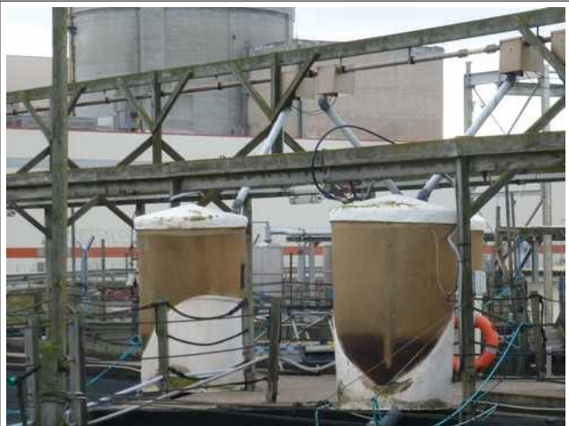
Le nourrissage des poissons est automatisé
